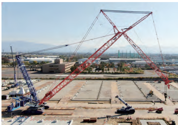
750トン吊りクローラークレーン
